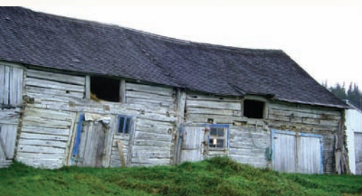
Courbe dans la ligne faîtière du toit qui révèle une faiblesse structurale.
