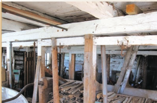
Des appuis verticaux additionnels aident à soutenir la structure.
