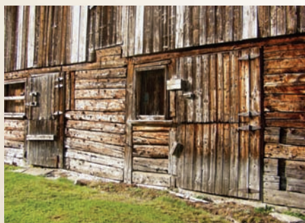
La technique d'assemblage en pièce sur pièce est composée de plusieurs pièces de bois massives empilées.
