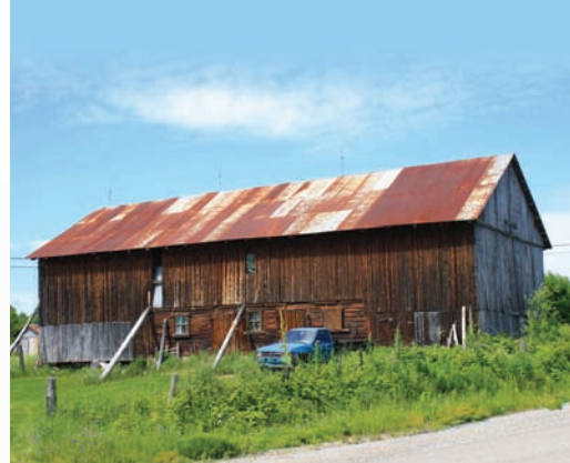
Des supports temporaires peuvent soutenir un mur déformé en attendant qu'il soit réparé.
