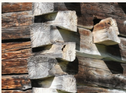
Les extrémités des pièces sont taillées à queue d'aronde [en forme de queue d'hirondelle] et s'emboîtent de façon à former un assemblage solide.
