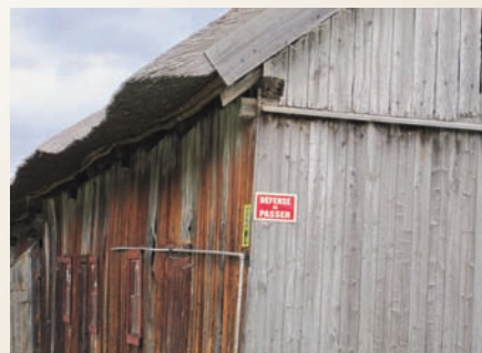
Le chaume de la grange Lajoie donne une surface irrégulière au toit.
