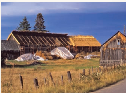
La restauration du toit en chaume de la grange Lajoie.
