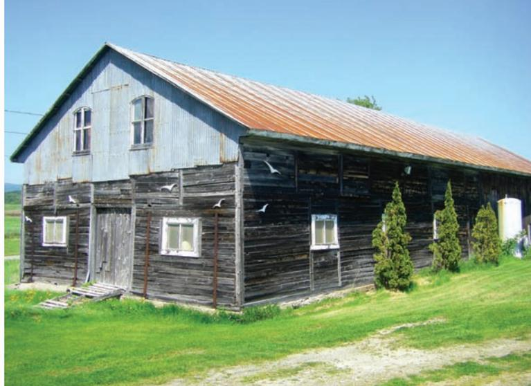
Cette construction en bois avait été entièrement recouverte de tôle de type industriel, aussi appelée tôle de grange. Il ne s'agit pas d'une exception : les murs et la toiture de bon nombre de bâtiments agricoles en bois ont subi le même sort. En retirant la tôle qui recouvrait ce bâtiment, on retrouve le bois d'origine.
