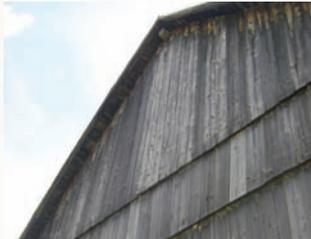
La **planche verticale**, emboutetée ou simplement juxtaposée, constitue l'assemblage le plus courant sur les bâtiments agricoles de Charlevoix. Lorsque plusieurs rangées de planches verticales se superposent, celles du haut sont légèrement en saillie par rapport à celles du bas, empêchant l'eau de pénétrer à l'intérieur de la structure.
